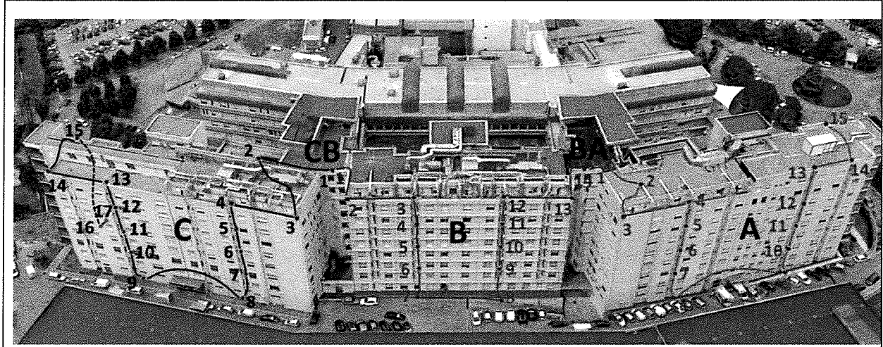
Fig.6 Disposizione punti di misura su immagine prospettica (vista da monte) del monitoraggio dinamico effettuato
